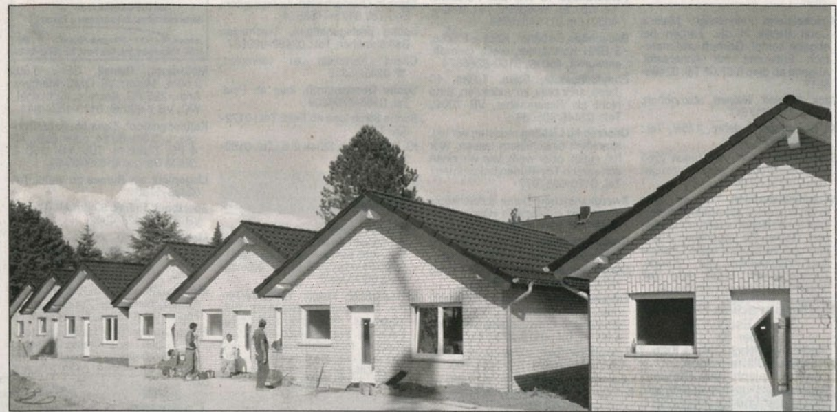
Blick auf die Bungalows des Wassenberger Seniorenwohnparks „Am Waldrand“ von der Straßenfront aus. Foto: pki
